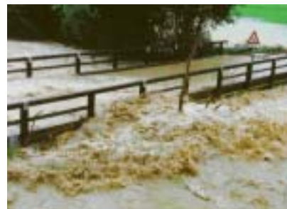
Risikofaktor Verklauung. Wenn Bäume den Durchfluss unter Brücken einengen, kann sich die Hochwassergefahr schlagartig zuspitzen.
