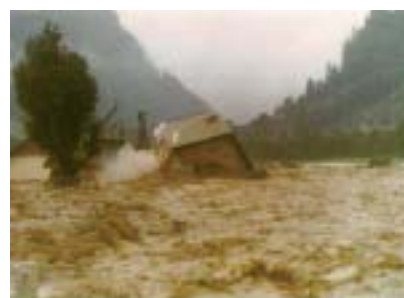
Gebäudeeinsturz durch Hochwasser. (Möll, Kärnten, 1965).
